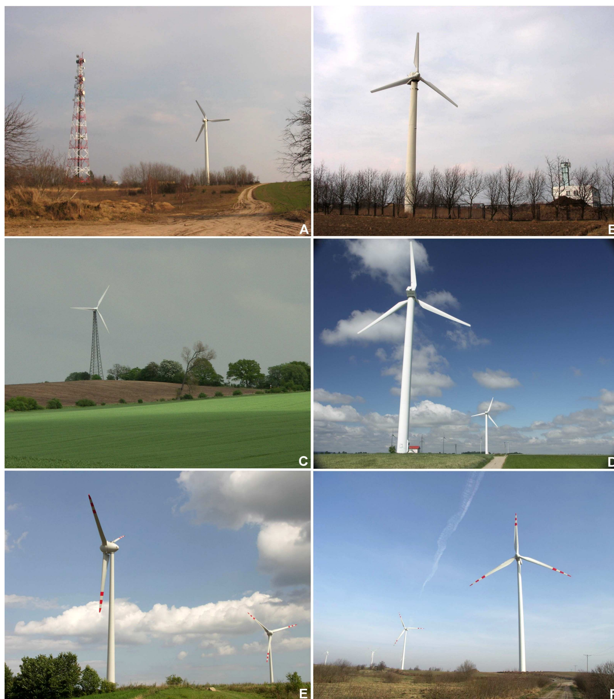
Fot. 11. Przykłady farm wiatrowych znajdujących się w strefie pobrzeży województwa pomorskiego: A - Lisewo k/Żarnowca (1 x 150 kW), B – Swarzewo/Pucka (1 x 95 kW, nieczynna), C – Starbienio k/Choczewa (1 x 250 kW), D – Swarzewo k/Pucka (2 x 600 kW), E - Połczyno k/Pucka (2 x 800 kW), F - Gnieźdzewo k/Pucka (11 x 2 MW)
