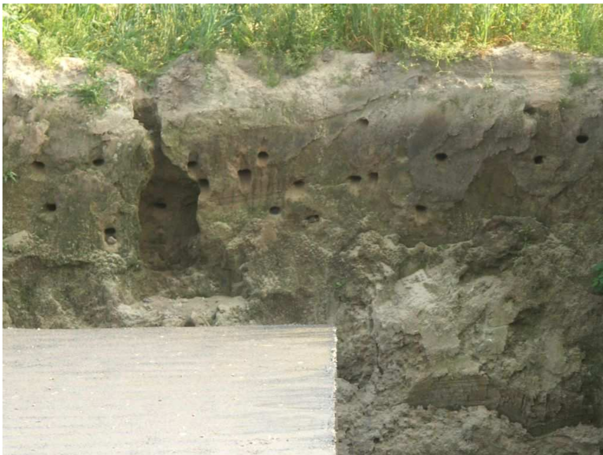
Fot. 2. Gniazdowisko jaskółek przy fundamentach farmy wiatrowej w Gnieździe, fotografia wykonana w lipcu 2006 roku
